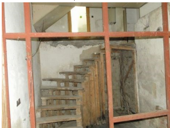
Vstupní chodba se schodištěm v 1.PP
