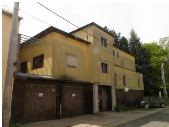
Uliční pohled na RD z ul. U Sýpky
