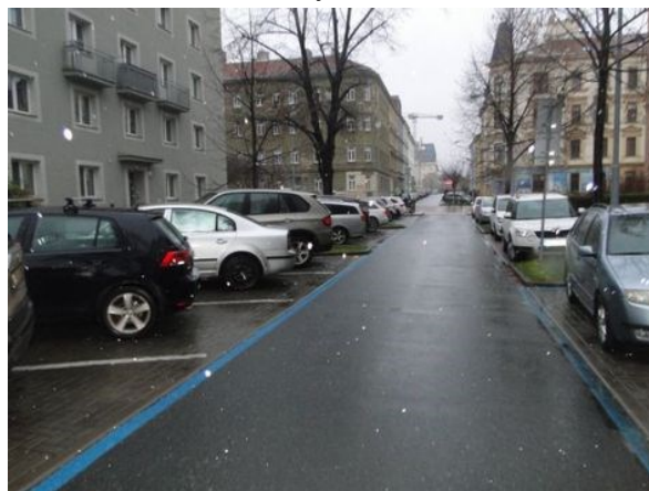
Přístupová komunikace k bytovému domu
