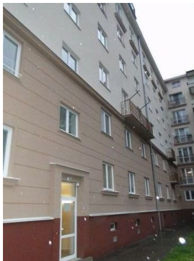
Dvorní pohled na bytový dům
